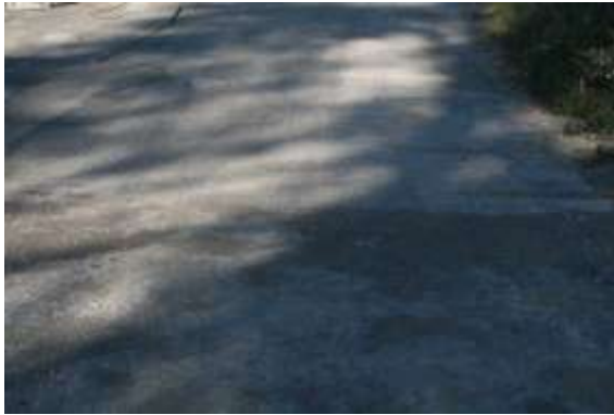
Εικόνα 1. Σύνδεση τμημάτων οδού Π-1 και Π-2. Αποθέσεις χωμάτων και λακκούβες στο τμήμα Π-1 (κάτω μέρος φωτογραφίας)
