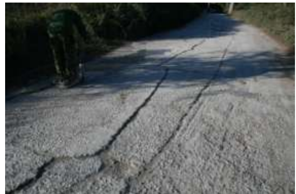
Εικόνα 4. Συνολική εικόνα τμήματος οδού Π-3
