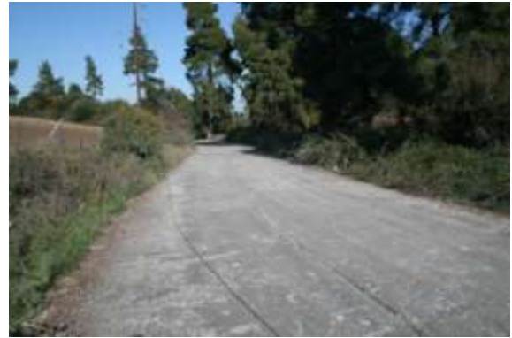
Εικόνα 2. Συνολική εικόνα τμήματος οδού Π-2
