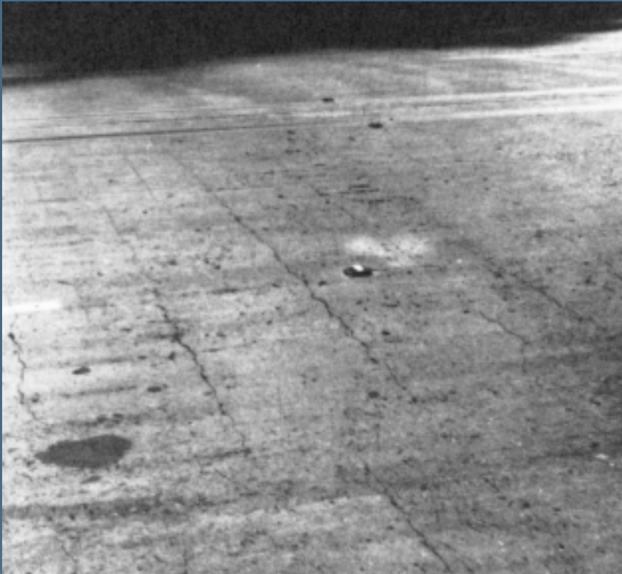
Εγκάρσιες ρηγματώσεις
