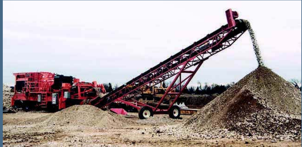
Διαδικασία ανακύκλωσης σκυρ/τος
