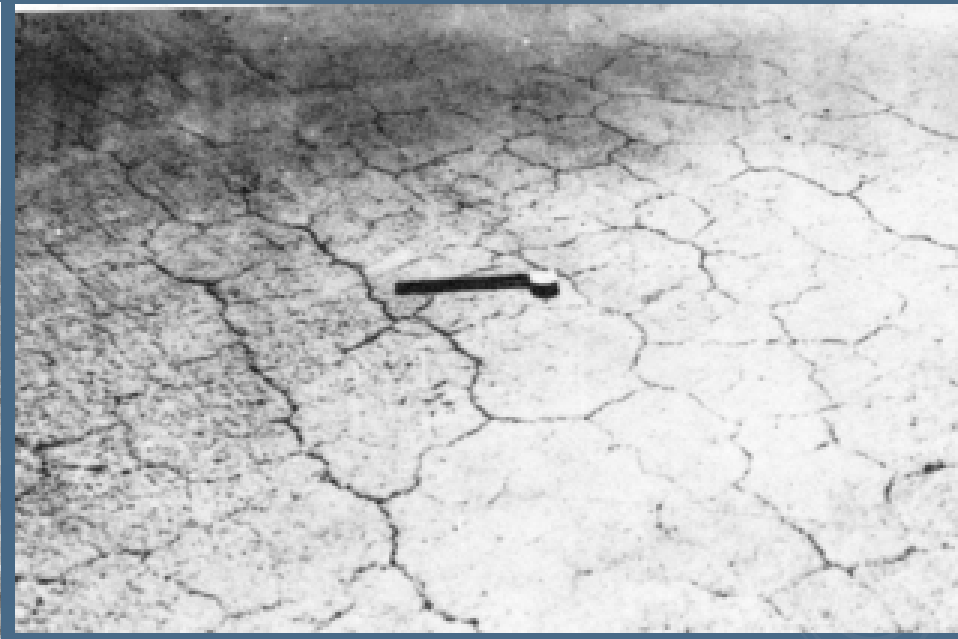
Ρηγματώσεις χαρακτηριστικού pattern
