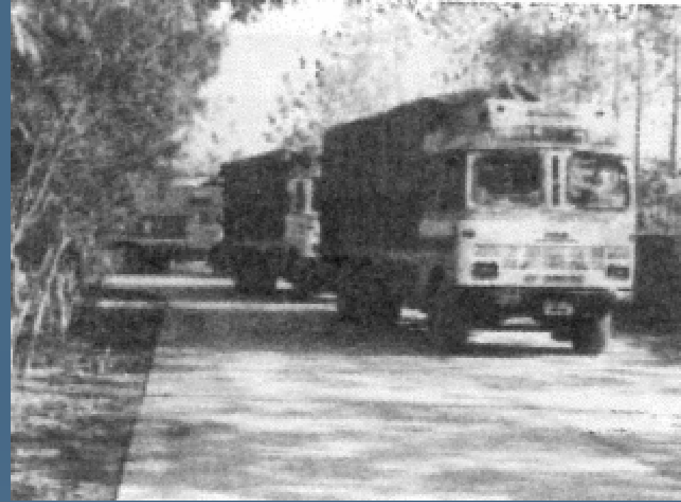
Οδόστρωμα HVFA στο Ambujanagar, Gujarat
