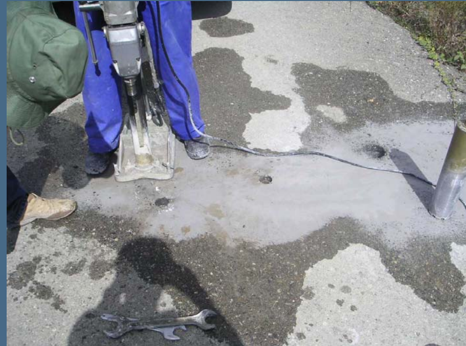
Εικόνα 4. Πυρηνοληψία σε θέση με ασφαλτική επικάλυψη
