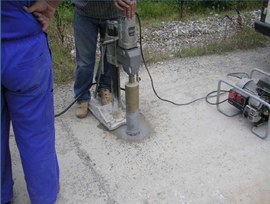
Εικόνα 3. Πυρηνοληψία σε θέση με καλά συμπυκνωμένο σκυρόδεμα
