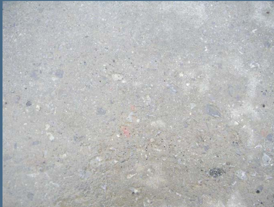
Εικόνα 9. Υγιές τμήμα στο κέντρο του δρόμου
