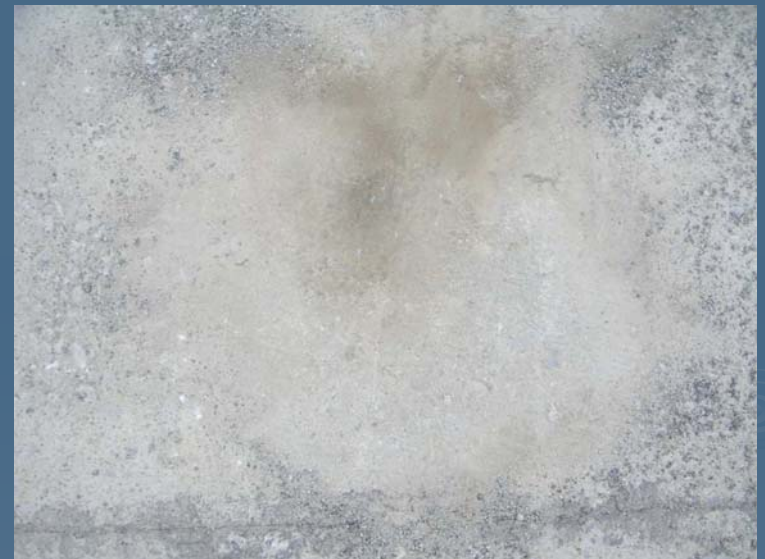
Εικ. 13. Λακκούβα μετά από καθαρισμό φερτών υλών
