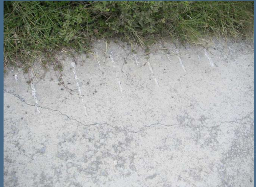
Εικόνα 14. Ρηγμάτωση στο άκρο του δρόμου
