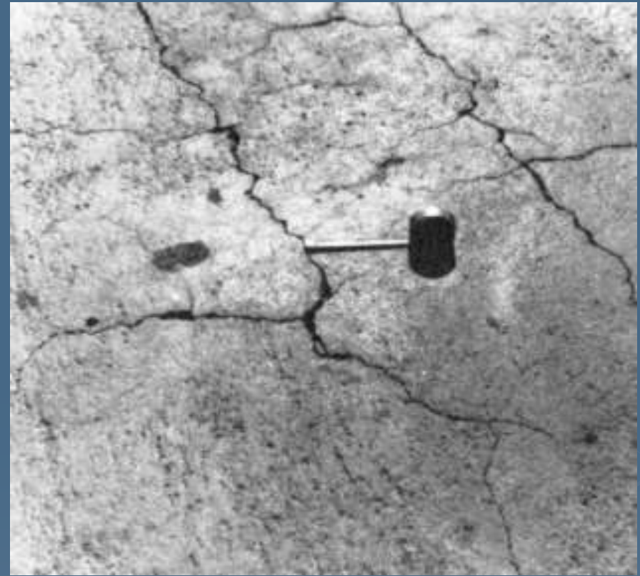
Ρηγματώσεις τυχαίου προσανατολισμού
