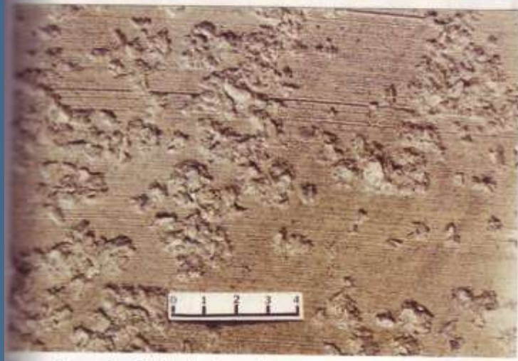
Αποφλοίωση επιφάνειας σκυροδέματος
