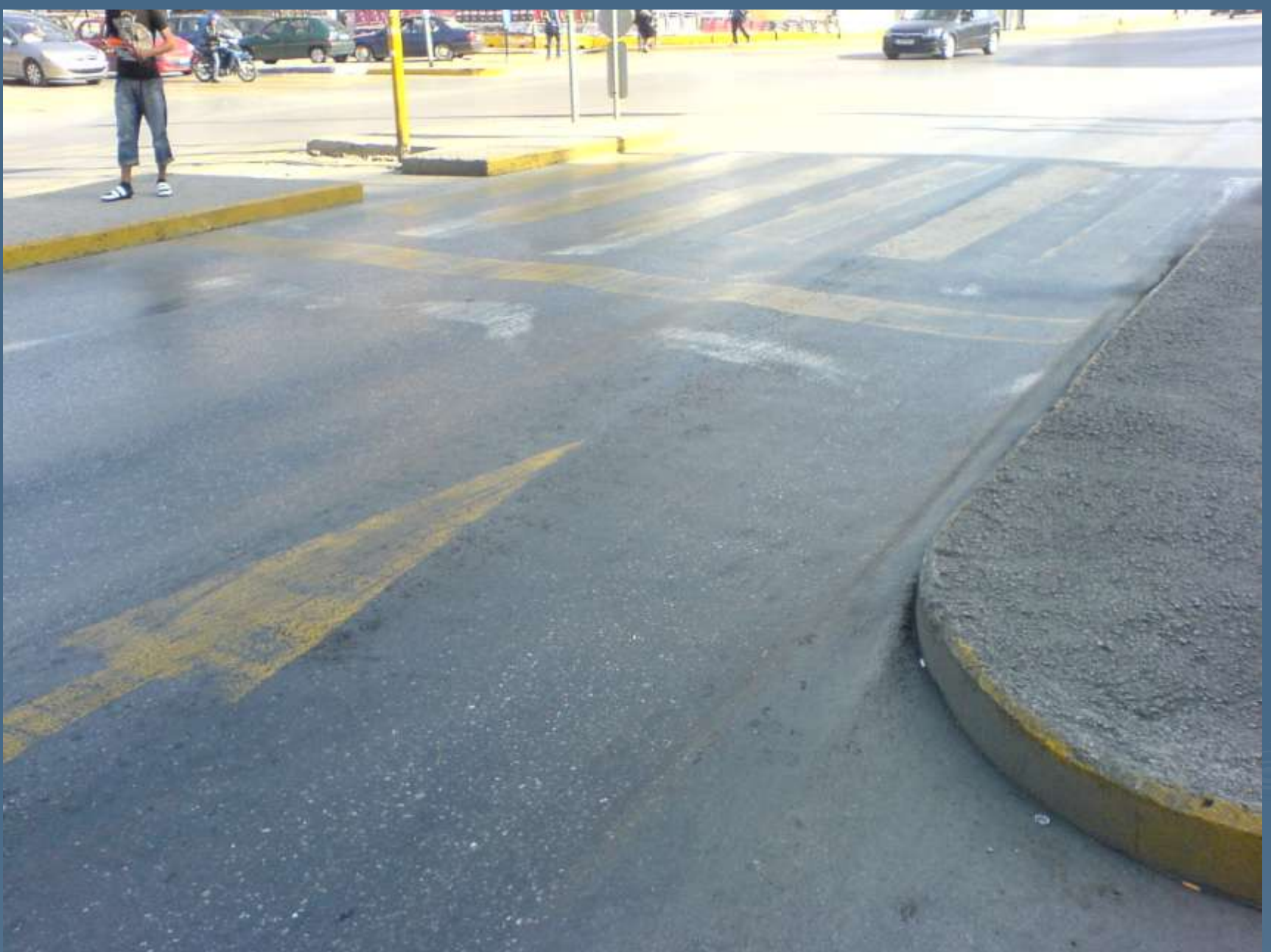
Ασφαλτοσκυρόδεμα κεντρικού δρόμου της Θεσσαλονίκης
