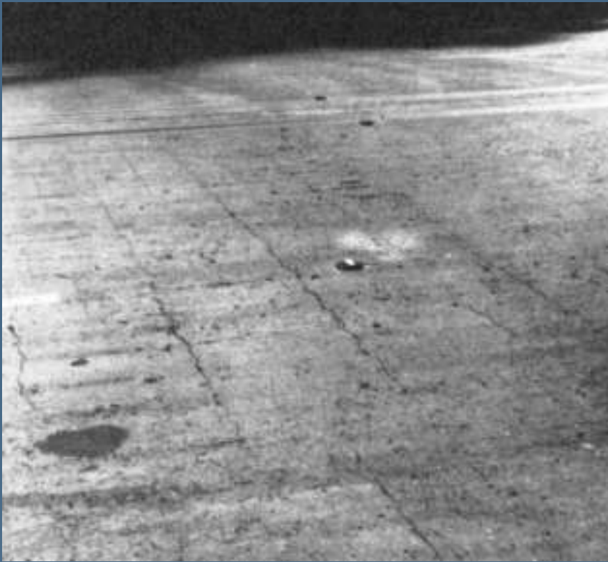
Εγκάρσιες ρηγματώσεις
