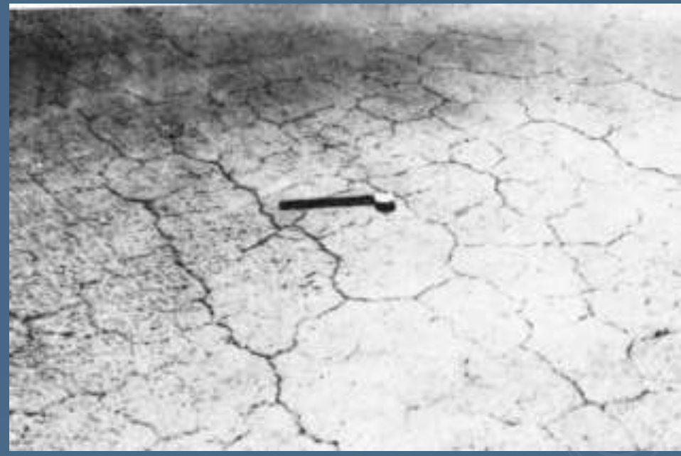
Ρηγματώσεις χαρακτηριστικού pattern
