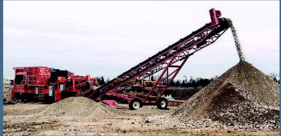
Διαδικασία ανακύκλωσης σκυρ/τος
