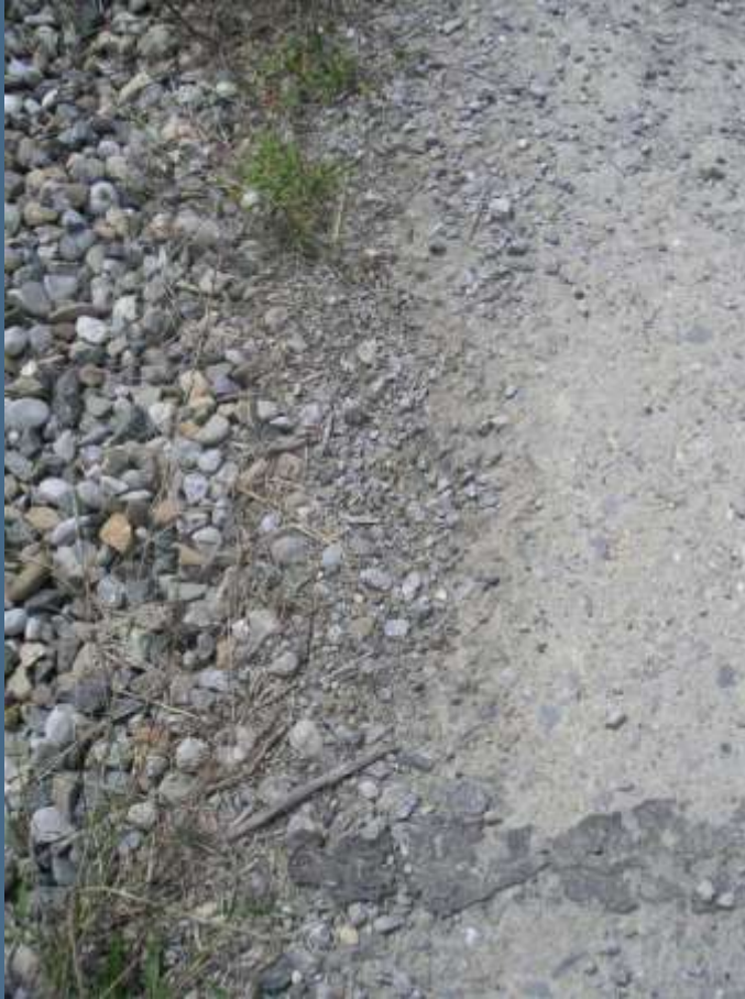
Εικόνα 5. Άκρο δρόμου χωρίς ασφαλτόστρωση
