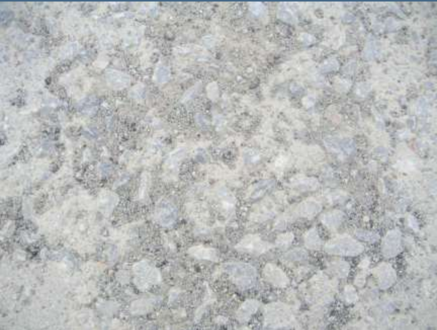
Εικόνες 10, 11. Διαβρωμένο τμήμα του δρόμου
