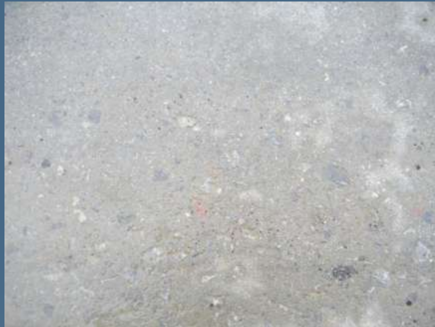
Εικόνα 9. Υγιές τμήμα στο κέντρο του δρόμου
