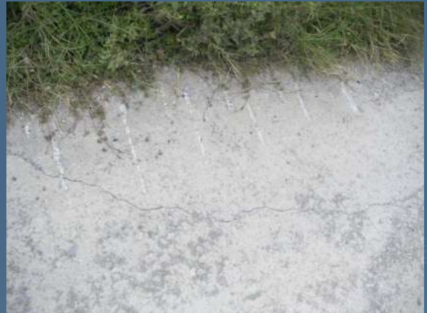
Εικόνα 14. Ρηγμάτωση στο άκρο του δρόμου
