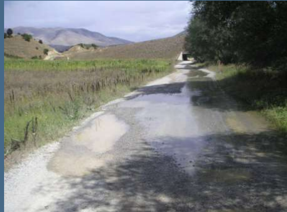
Εικόνα 2. Διαβροχή δρόμου από άρδευση γειτονικών αγρών
