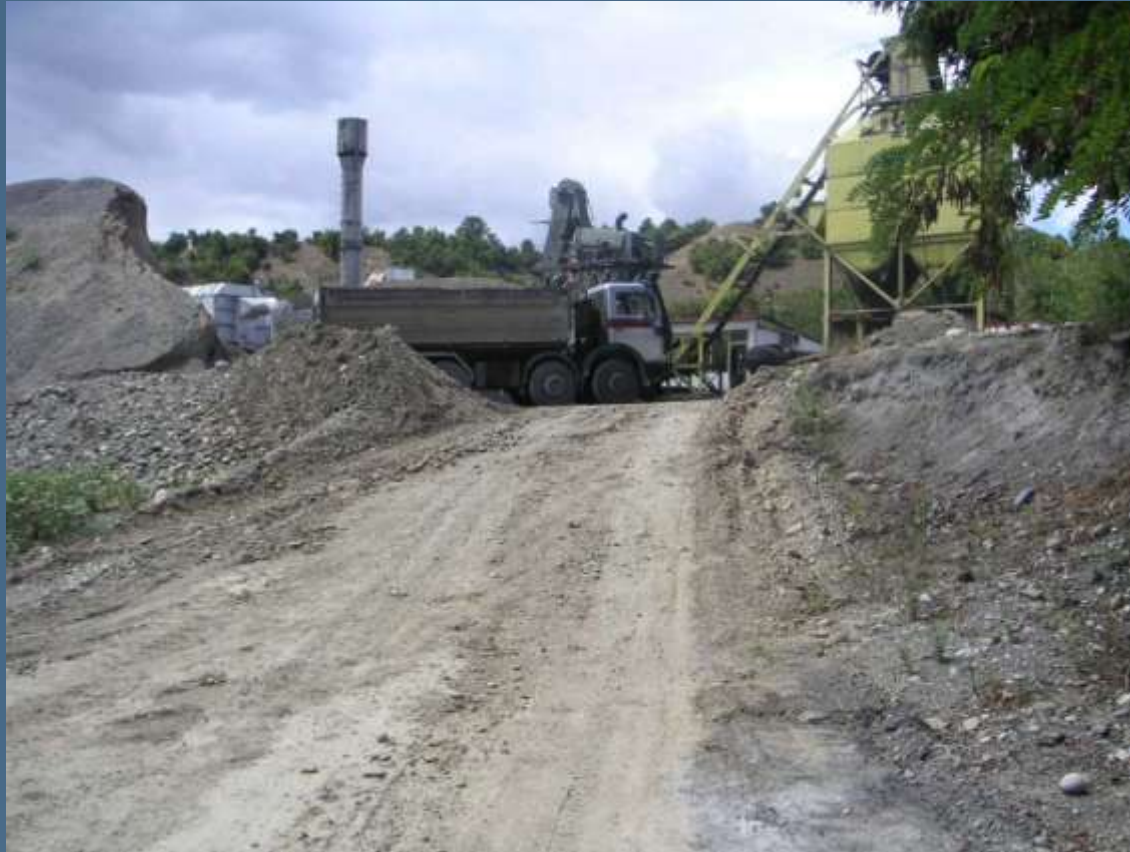
Εικόνα 1. Γειτονικό εργοστάσιο ασφάλτου
