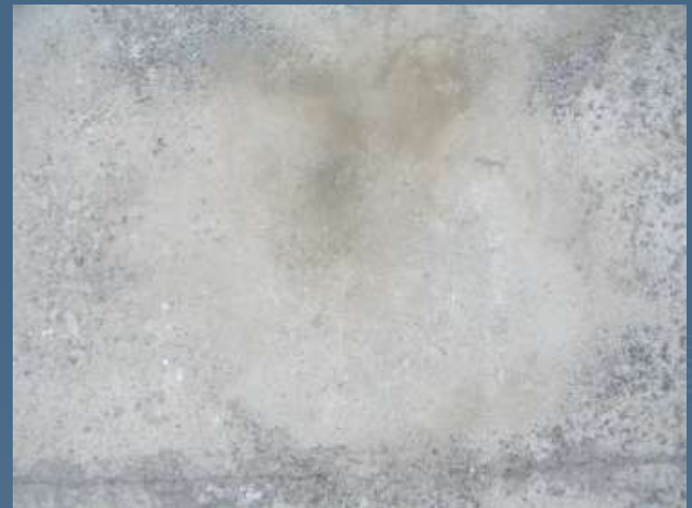
Εικ. 13. Λακκούβα μετά από καθαρισμό φερτών υλών
