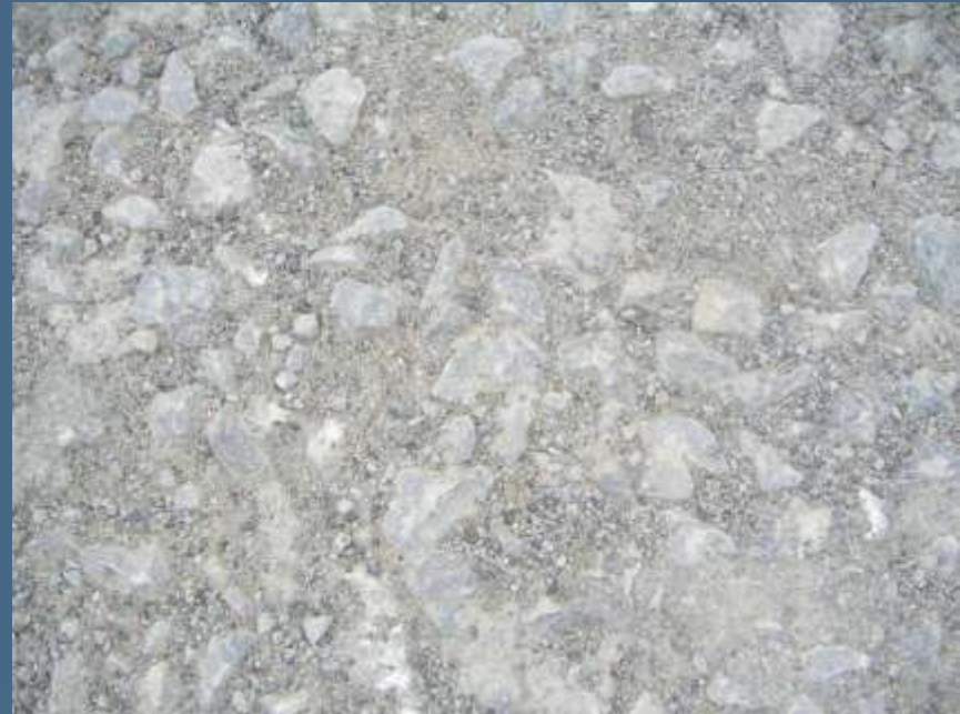
Εικόνες 10, 11. Διαβρωμένο τμήμα του δρόμου
