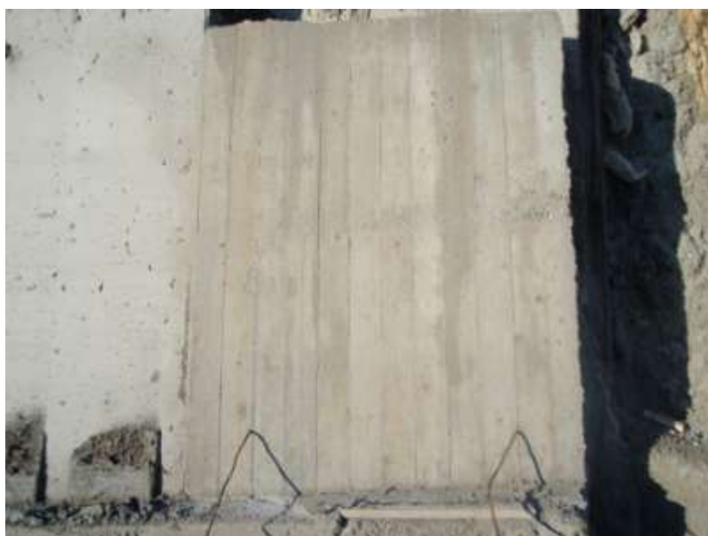
Εικόνα 2. Ικανοποιητική τελική επιφάνεια με τη χρήση κατάλληλων ξυλότυπων
