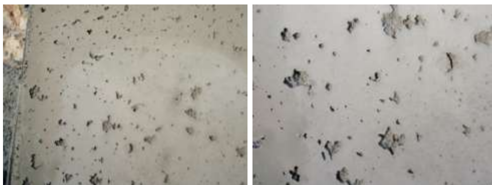
Εικόνα 1. Εμφάνιση κυμαλών στην τελική επιφάνεια του σκυροδέματος
