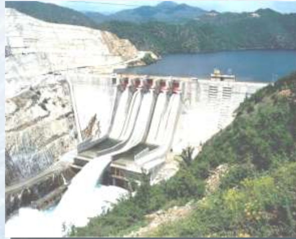
Φράγμα Πλατανόβρυσης, Ελλάδα
