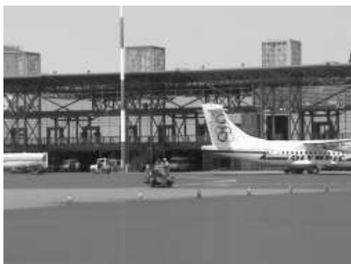
Φωτογραφία 1: Εφαρμογή microsurfacing με σκωρία τύπου II (αεροδρόμιο Θεσ/νίκης 2004)
