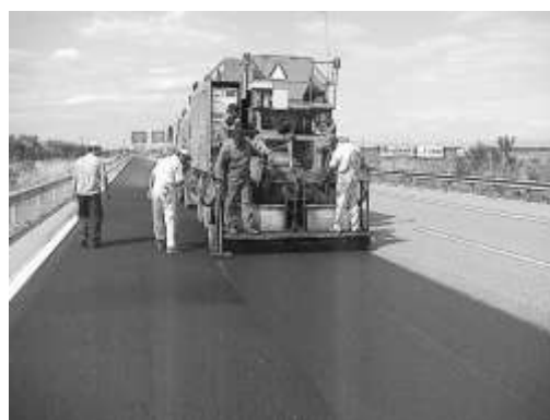
Φωτογραφία 2: Εφαρμογή microsurfacing με σκωρία τύπου III (ΠΑΘΕ, 460 ο χλμ Ε.Ο.Αθήνα- Θεσ/νίκης 2005)
