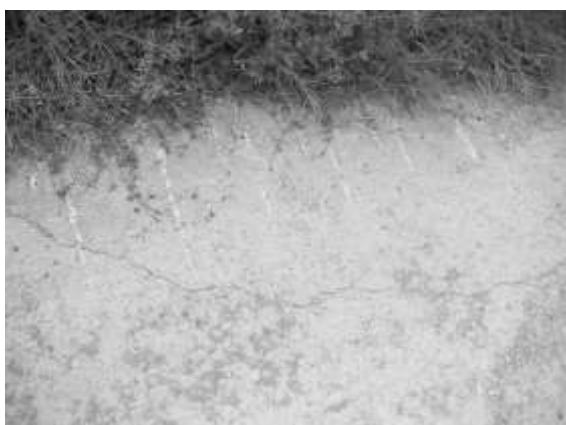
Εικόνα 14. Ρηγματώση στο άκρο του δρόμου
