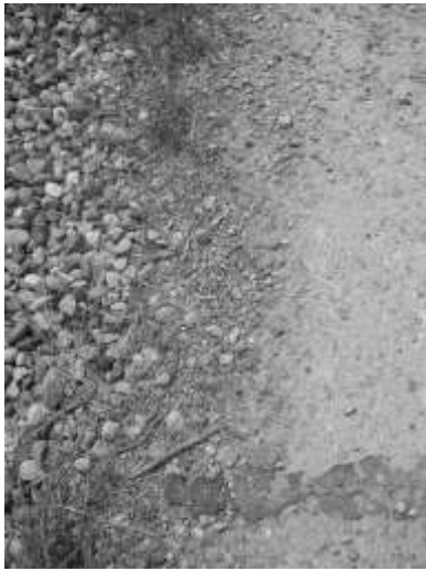
Εικόνα 5. Άκρο δρόμου χωρίς ασφαλτόστρωση
