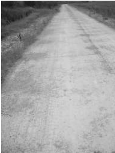
Εικόνα 7. Τμήμα δρόμου χωρίς ασφαλτόστρωση. Διάβρωση στα ακραία τμήματα
