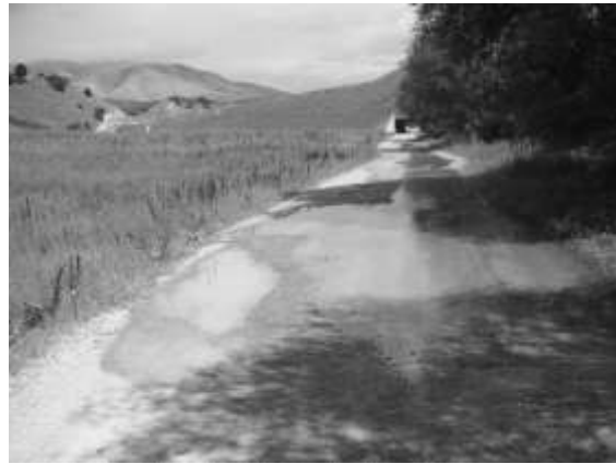
Εικόνα 2. Διαβροχή δρόμου από άρδευση γειτονικών αγρών
