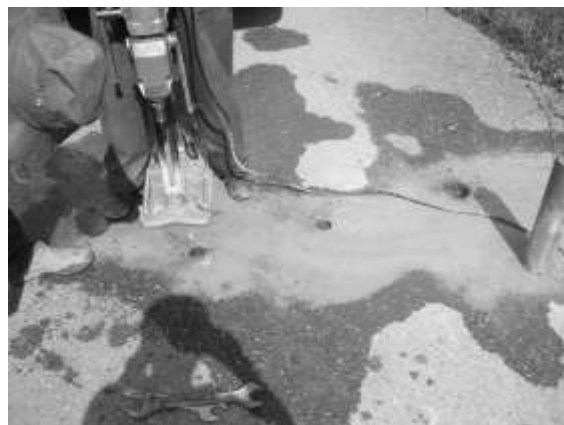
Εικόνα 4. Πυρηνοληψία σε θέση με ασφαλτική επικάλυψη
