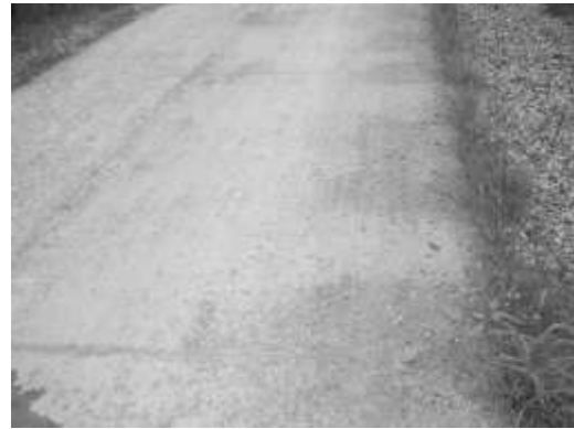
Εικόνα 8. Τμήμα δρόμου με ασφαλτόστρωση. Διάβρωση στα ακραία τμήματα
