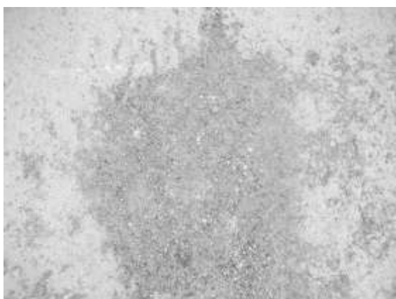
Εικόνα 12. Λακούβα πριν από καθαρισμό φερτών υλών
