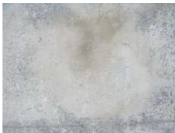
Εικόνα 13. Λακούβα μετά από καθαρισμό φερτών υλών
