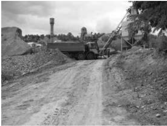
Εικόνα 1. Γειτονικό εργοστάσιο ασφάλτου
