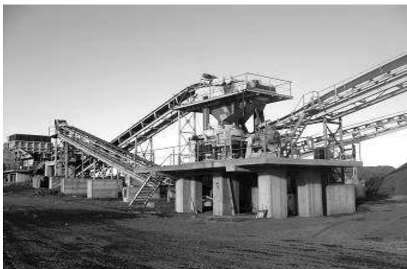
Εικόνα 1. Μονάδα επεξεργασίας σκωριών ηλεκτρικού κλιβάνου
